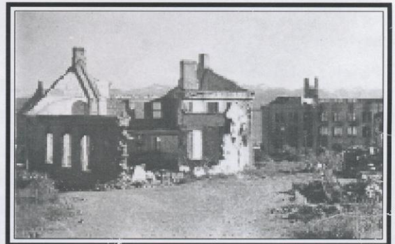
Ruinene av Frelsesarméens hus er i forgrunnen. Til høyre på bildet er ruinene av Superbgården. Gården var opprinnelig på 3 etasjer med mønetak. Den hadde buede vinduer i 1. etasje og vanlige firkantede vindusåpninger i de 2 øverste. Det ble så gjenoppbygget med 4 fulle etasjer med flatt tak. Huset var tegnet av en fremragende arkitekt, professor Sverre Pedersen ved NTH. Bygningen stod ferdig i 1917 og hadde da installert byens første heis.
