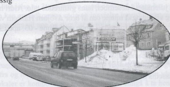
Situasjonsrapport 22.03.2000 kl. 0930. Stillaser er oppkommet rundt hele huset. Tilbygg mot syd er godt i gang - nå begynner arbeidet med taket! Vi skimter byggekomitéformannens bil. Han er der!
